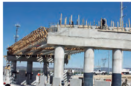
Construcción de autopista
