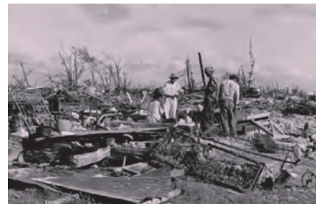
El huracán Janet destruye Chetumal en 1955
