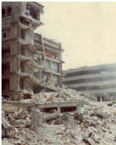
Afectaciones en la Ciudad de México por los sismos en 1985 y 2017
