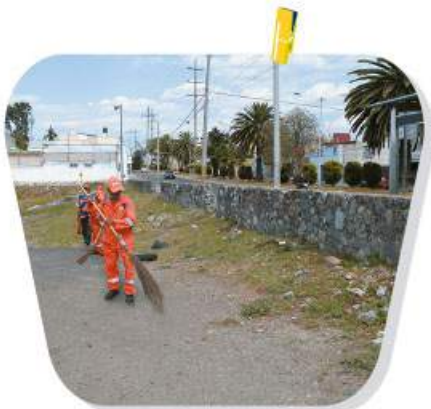
› Limpieza preventiva en el Puente negro
