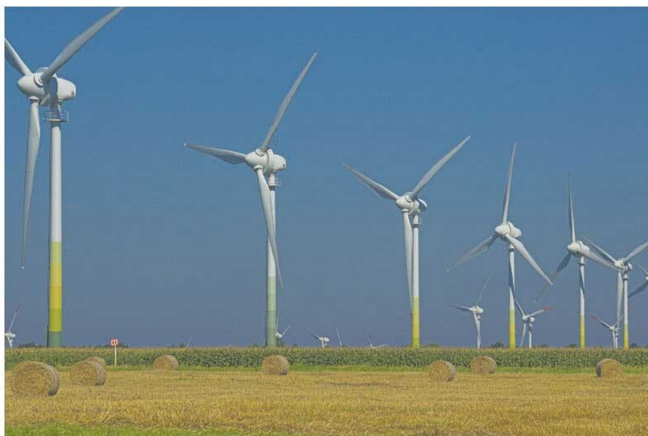
◆ Turbinas de viento en Alemania.
