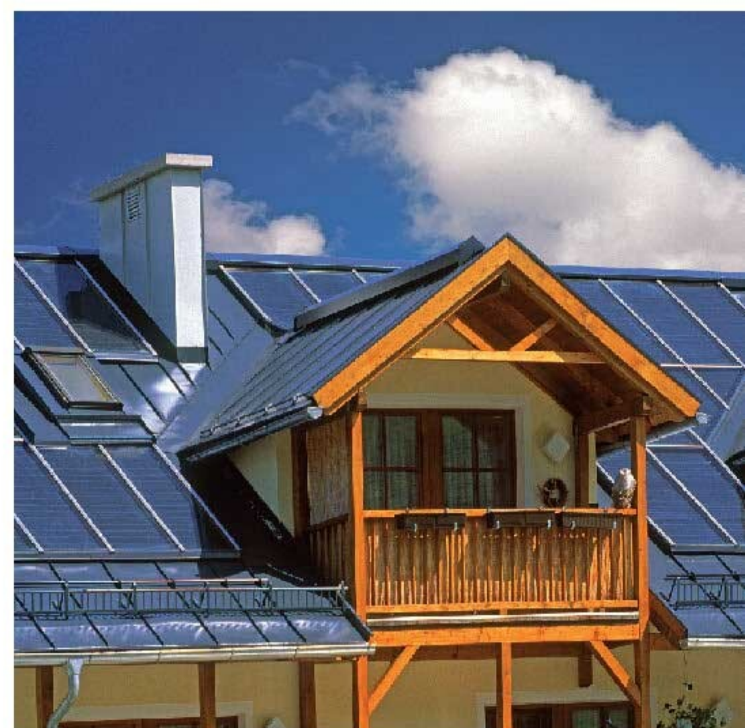
◆ Paneles solares en Viena, Austria.
