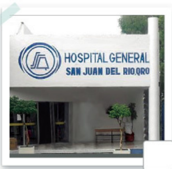
> Hospital General de San Juan del Río (1996)
