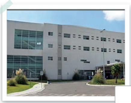
> Nuevo Hospital General de San Juan del Río (2012)
