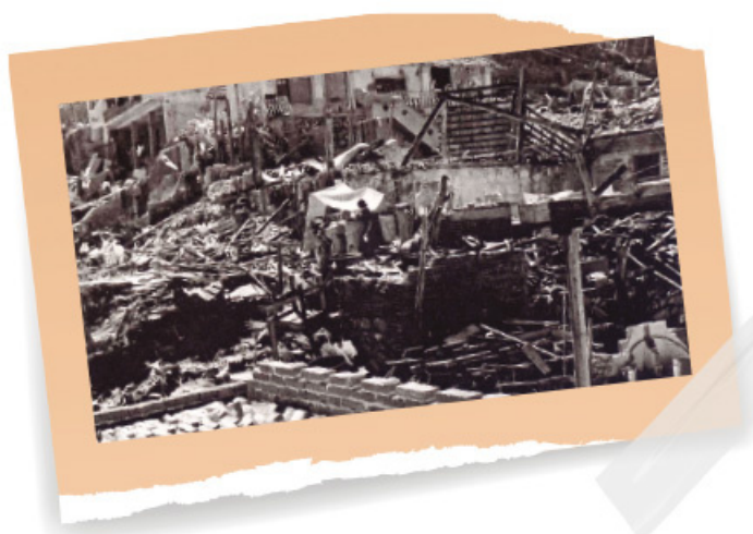
◆ Viviendas destruidas en el centro del puerto de Manzanillo por el paso del ciclón del 27 de octubre de 1959.
