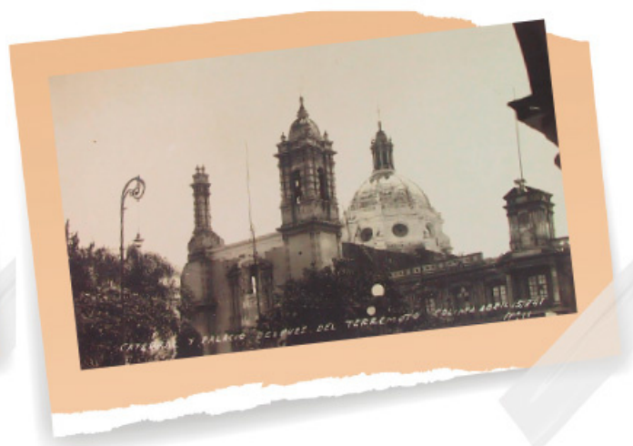
◆ La torre norte de la catedral de la ciudad de Colima fue destruida por el terremoto del 15 de abril de 1941.
